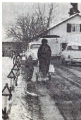
«Eine gefährliche Passage»: Der Bau der Grüningerstrasse-Brücke verzögerte sich.
